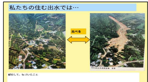
【図1】 針原地区土石流災害の様子
